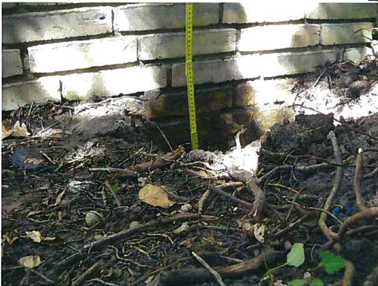
Teglsten ses i en dybde af minimum 40cm under terræn.
